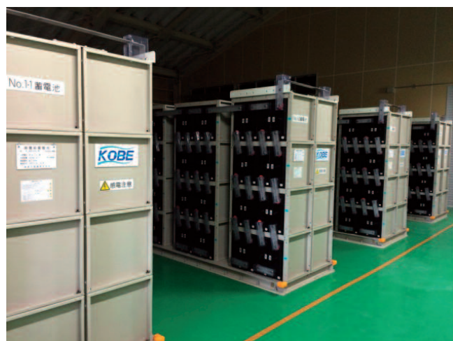
蓄電池設備 (鉛蓄電池)
