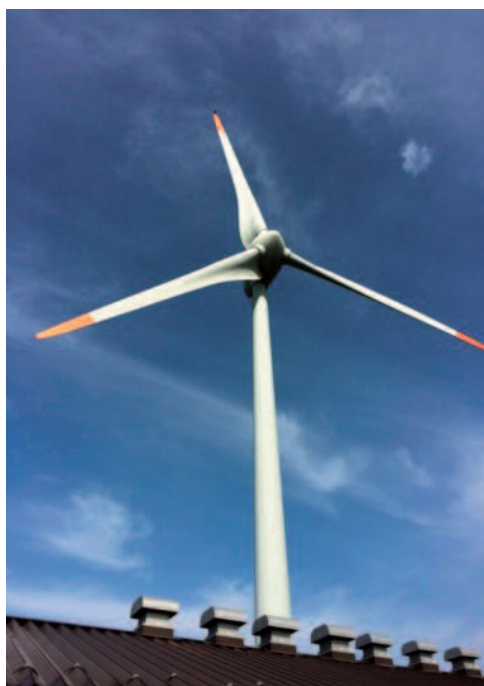
風太風力発電所の発電機 (2,300kW/基)
