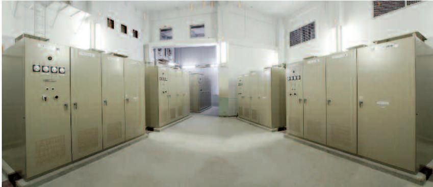
上福岡き電区分所に設置された回生電力貯蔵装置「E<sup>3</sup>Solution System」
