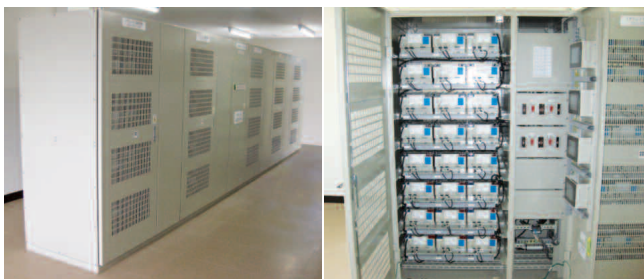
平泉駅に納入したリチウムイオン電池蓄電システム
