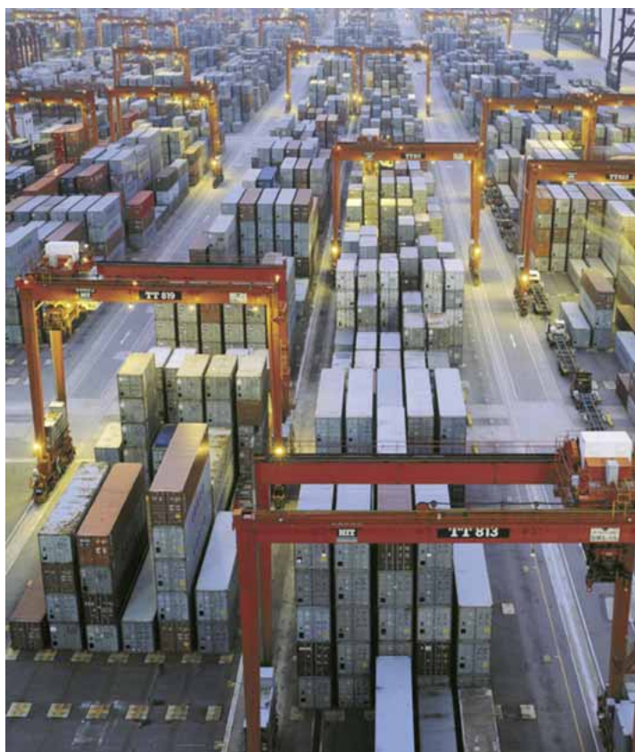
トランスファークレーン：住友重機械エンジニアリング サービス株式会社殿ご提供
